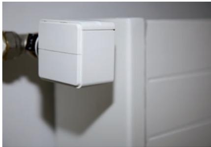
Le servomoteur reçoit des ordres du module ALADIN AMD après transmission des données de la sonde de température ambiante et du contact de fenêtre – par câble ou par ondes radio.
